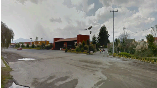
Acceso principal y colindancia.
